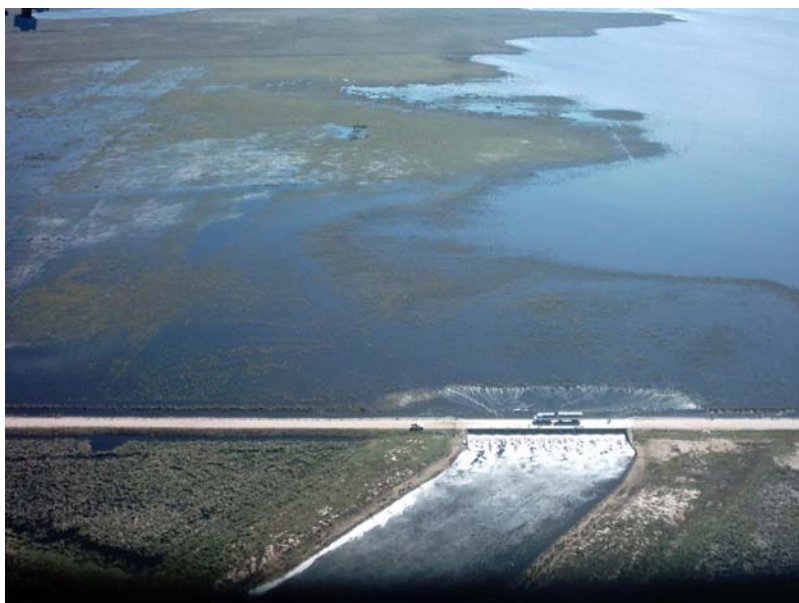
2007, Rufino: Vertedero 7 de la Picasa. Esta foto fue tomada desde el aire. Se observa en el vertedero, el caudal que aliviaba la carga hídrica de la laguna. (Gentileza del Ing. Agrónomo Mario Monti).
